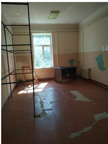
Складское помещение до ремонта
